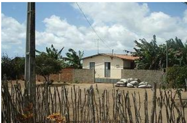
Fotografia 1 – Vista frontal da moradia dos assentados, Vale do Lírio, 2004
